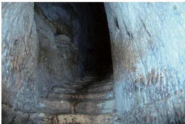
基遍水利工程的隧道
