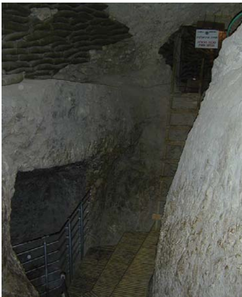
华伦竖坑入口至通往水塔的隧道
